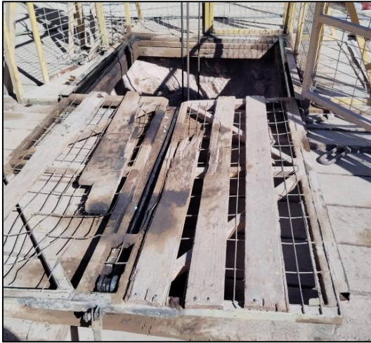
Figura 5: Medida de seguridad para cerrar entrada de a pique .
