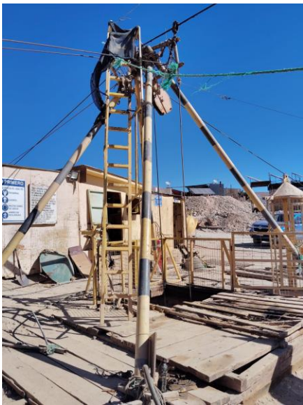
Figura 8: Sistema de extracción vertical Mina la perdida
